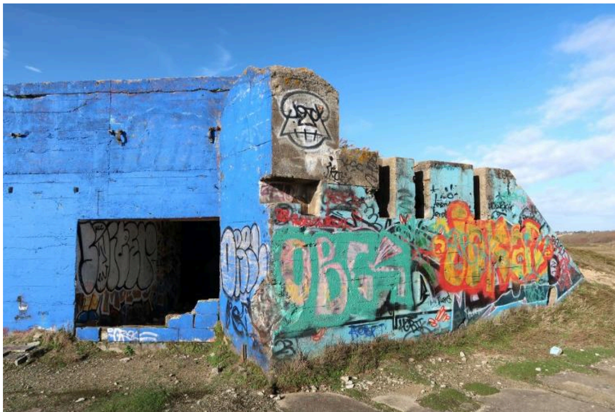
Vue du bunker - cuve nord pour canon de 34 cm avec magasins de munitions
