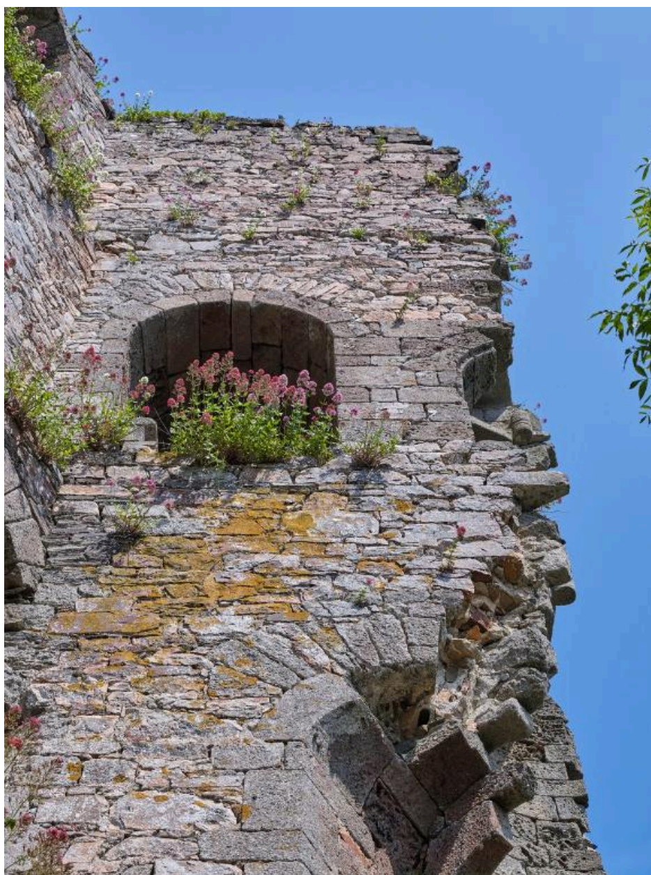
Vue du 2ème étage : baie orientée vers l'Est avec coussiège (vue en contreplongée)
