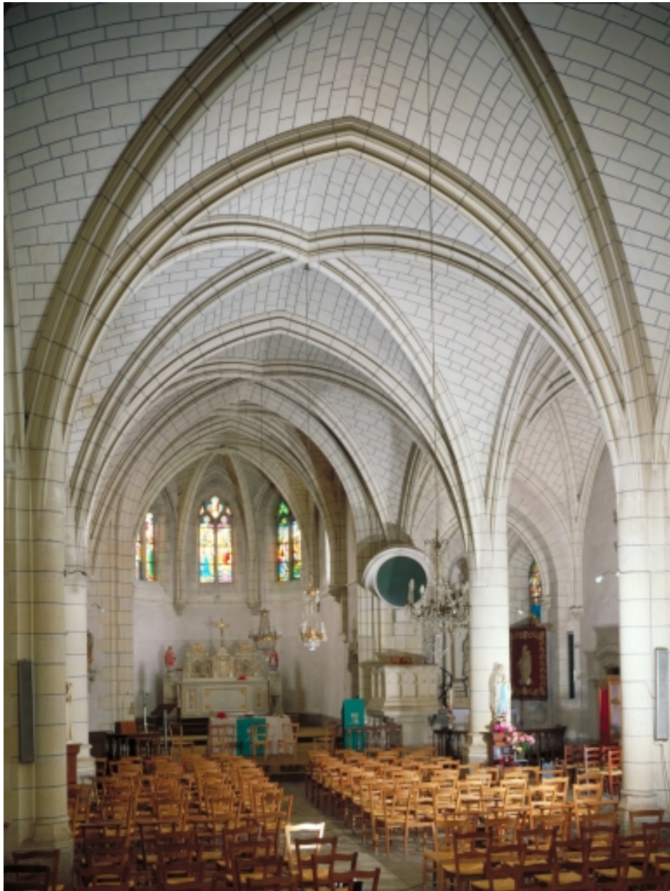
Vue générale vers le chœur en 1992
