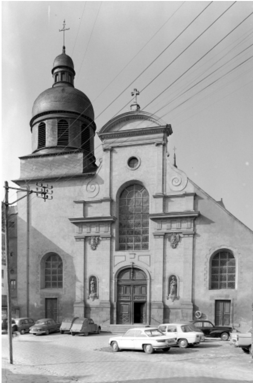
Rennes - Eglise Saint-Etienne - Elévation est, vue générale.
