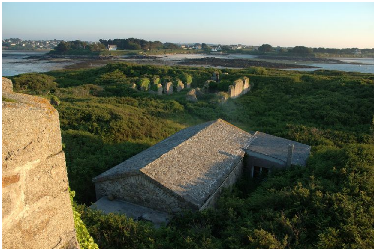
Vue de situation du magasin à poudre du fort Cézon
