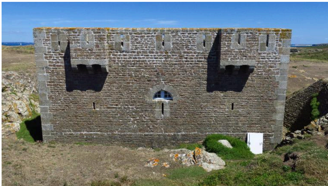
Île-d'Houat, batterie du Béniguet, corps de garde crénelé, façade ouest.
