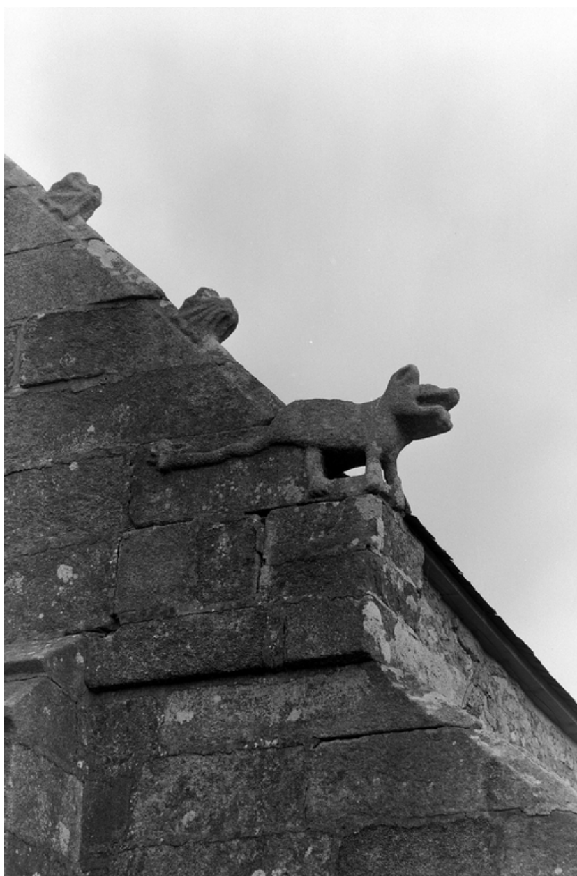
Façade ouest : détail de la pierre d'assise sculptée du rampant sud
