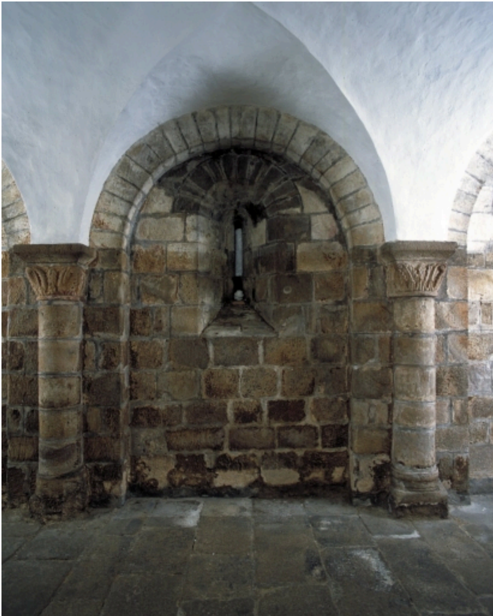
Crypte, mur sud, partie centrale
