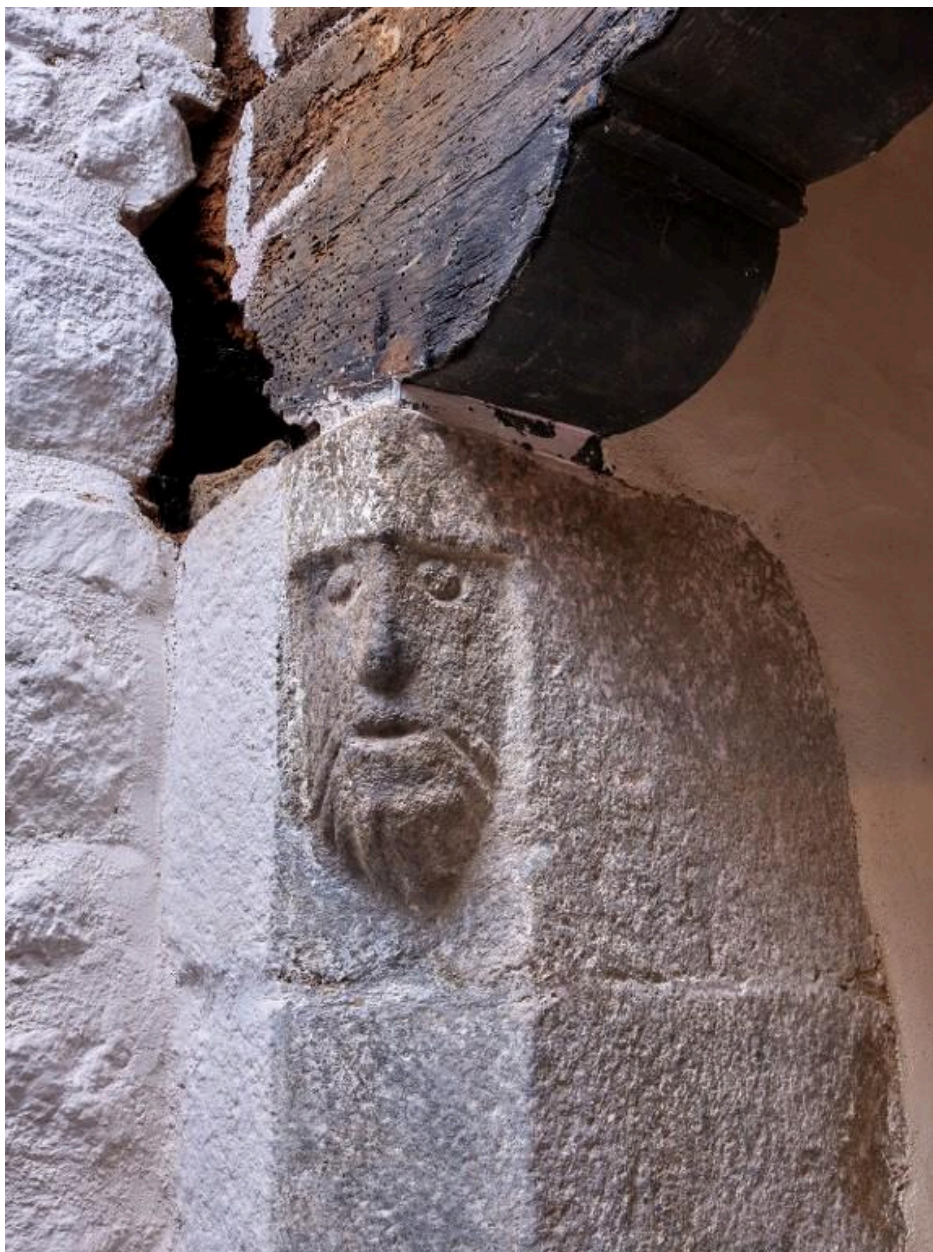
Logis principal. Chambre ouest de l'étage. Cheminée sur le pignon ouest. Détail d'un jambage avec visage barbu sculpté dans la partie supérieure
