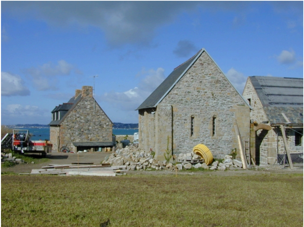
Vue Est de la chapelle, du chevet, en cours de restauration en 2004 (SRA)
