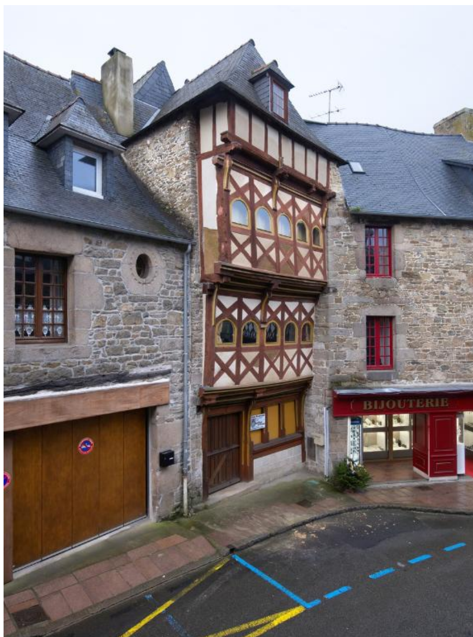
Façade sur rue. Vue générale sud-est
