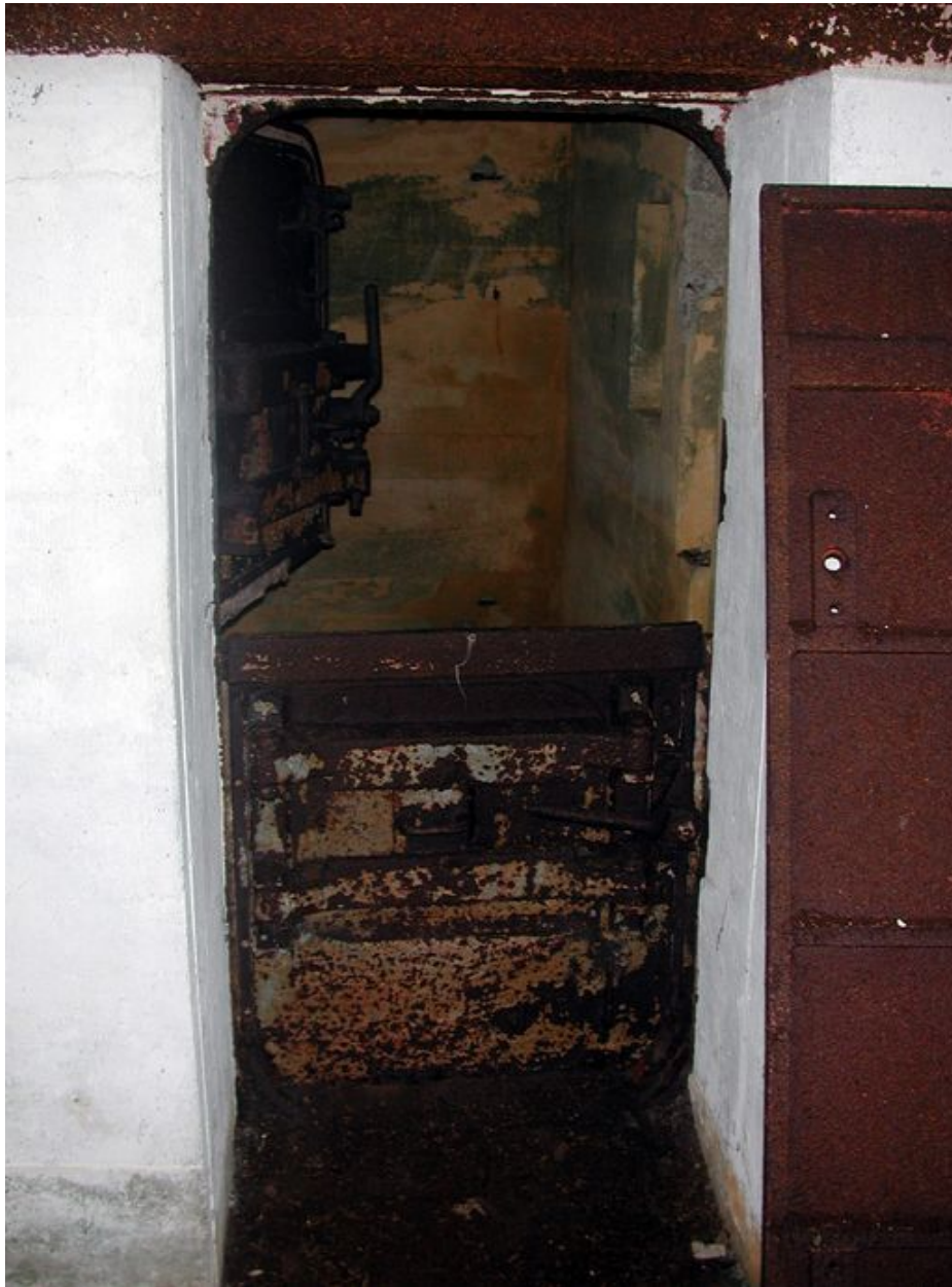
Vue de la porte blindée à deux vantaux du sas (état en 2003)
