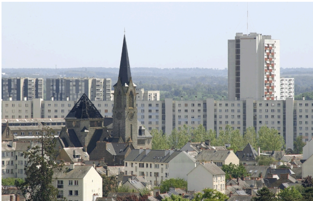
Vue de situation prise du nord-ouest
