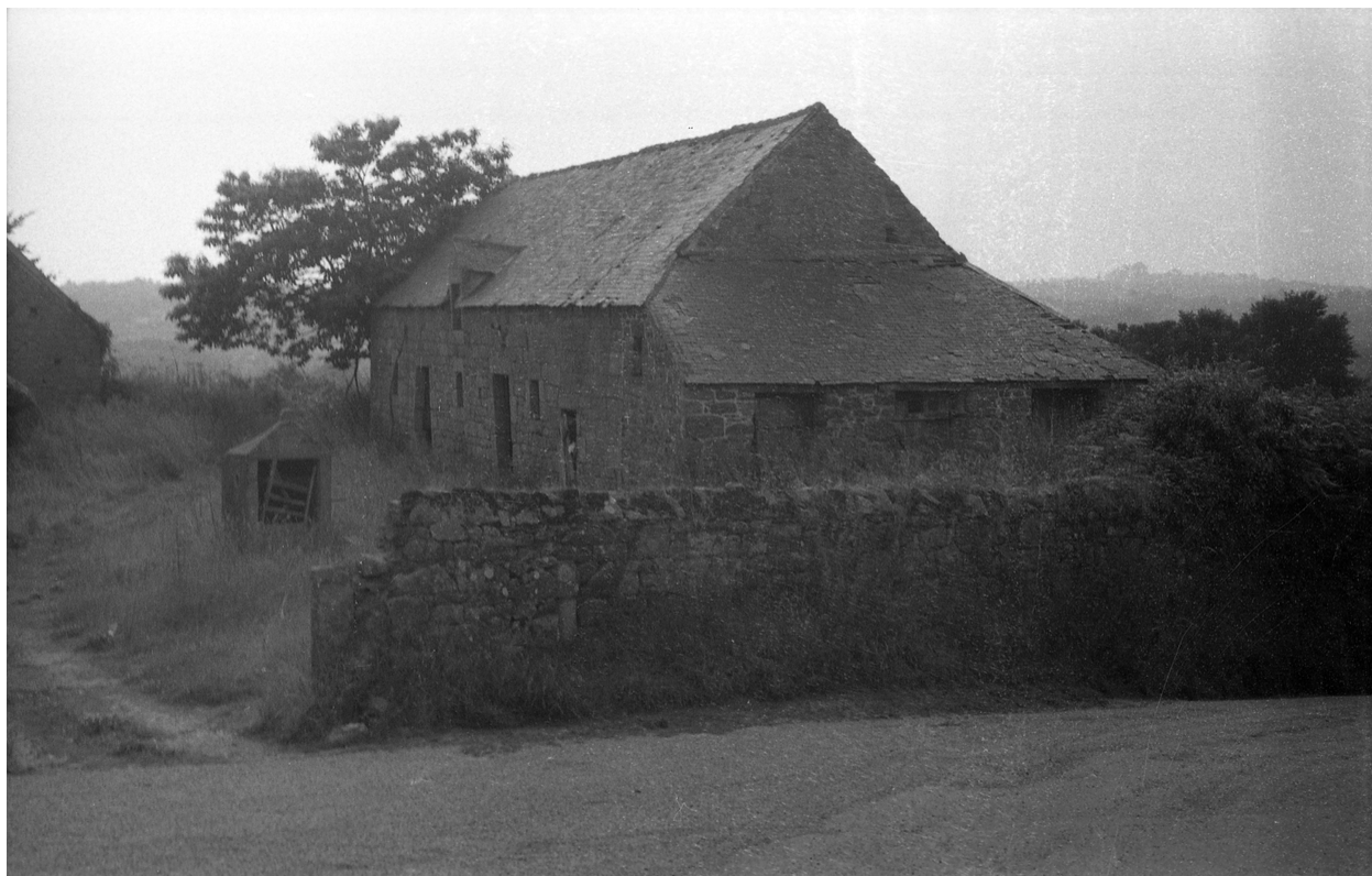
Vue générale de la façade sud
