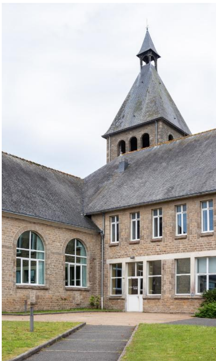
Jonction des ailes est et nord, prise du nord-est. A l'arrière plan, le campanile. Georges-Robert Lefort, architecte, 1929.
