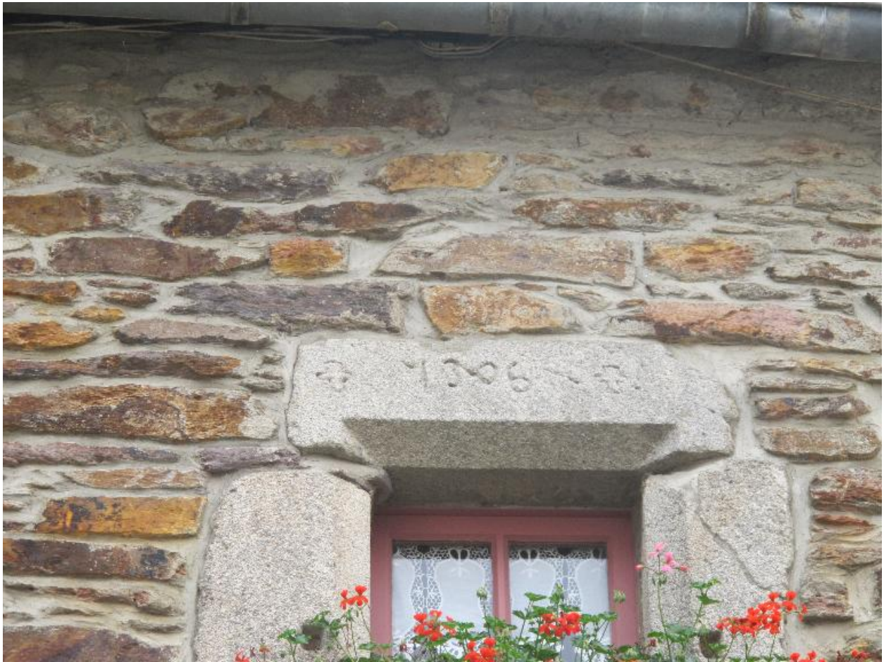
Maison, élévation donnant sur la rue Madame : le linteau de la petite fenêtre porte la date 1506 (état en 2012)
