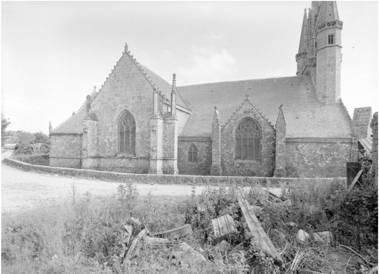
Façade nord, vue générale.
