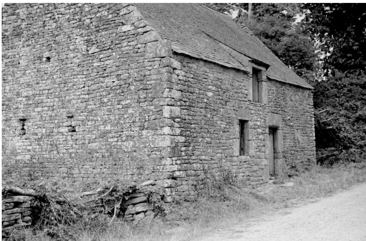
Ferme 8 (état en 1969)
