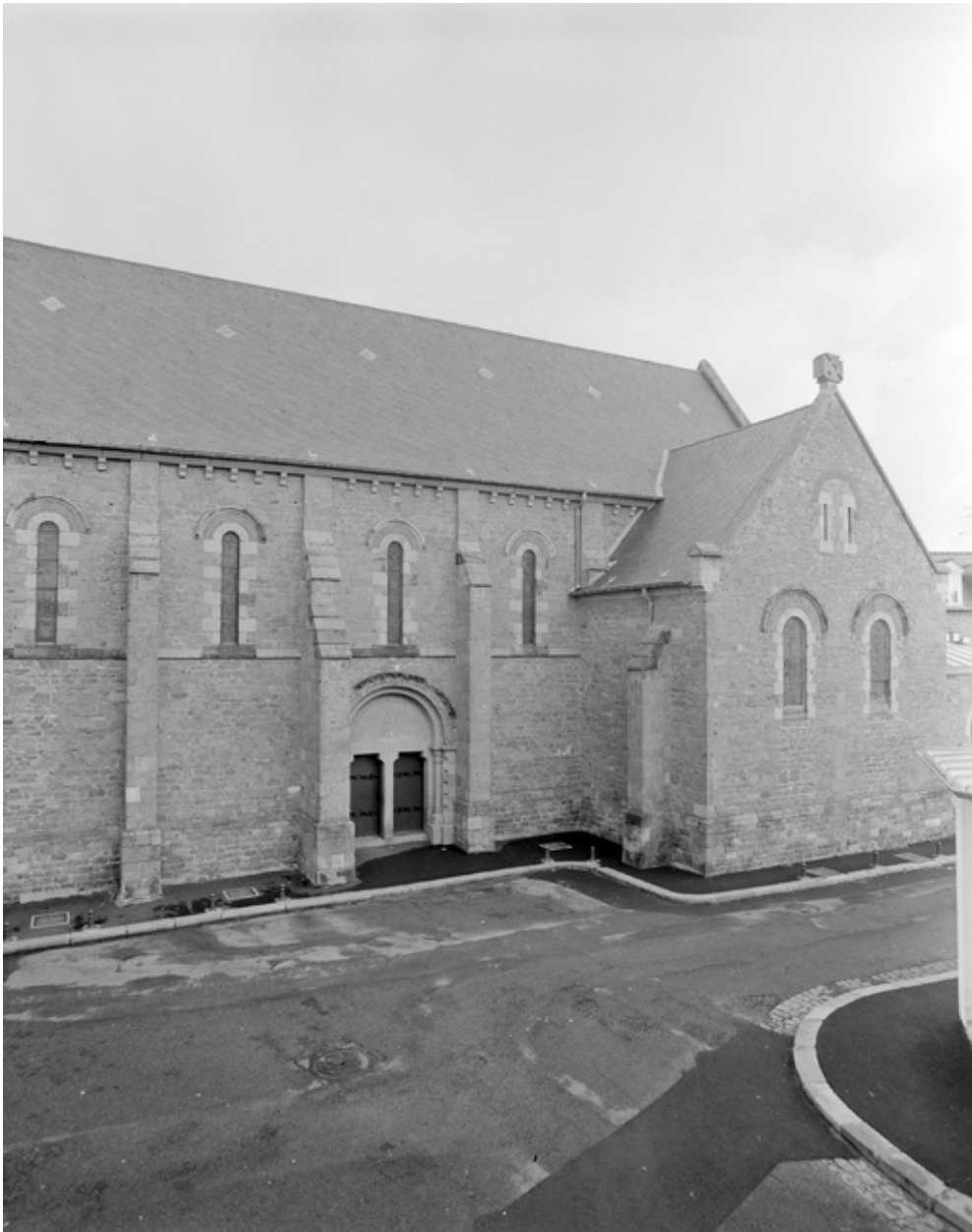
Elévation Sud, partie Est : vue générale.
