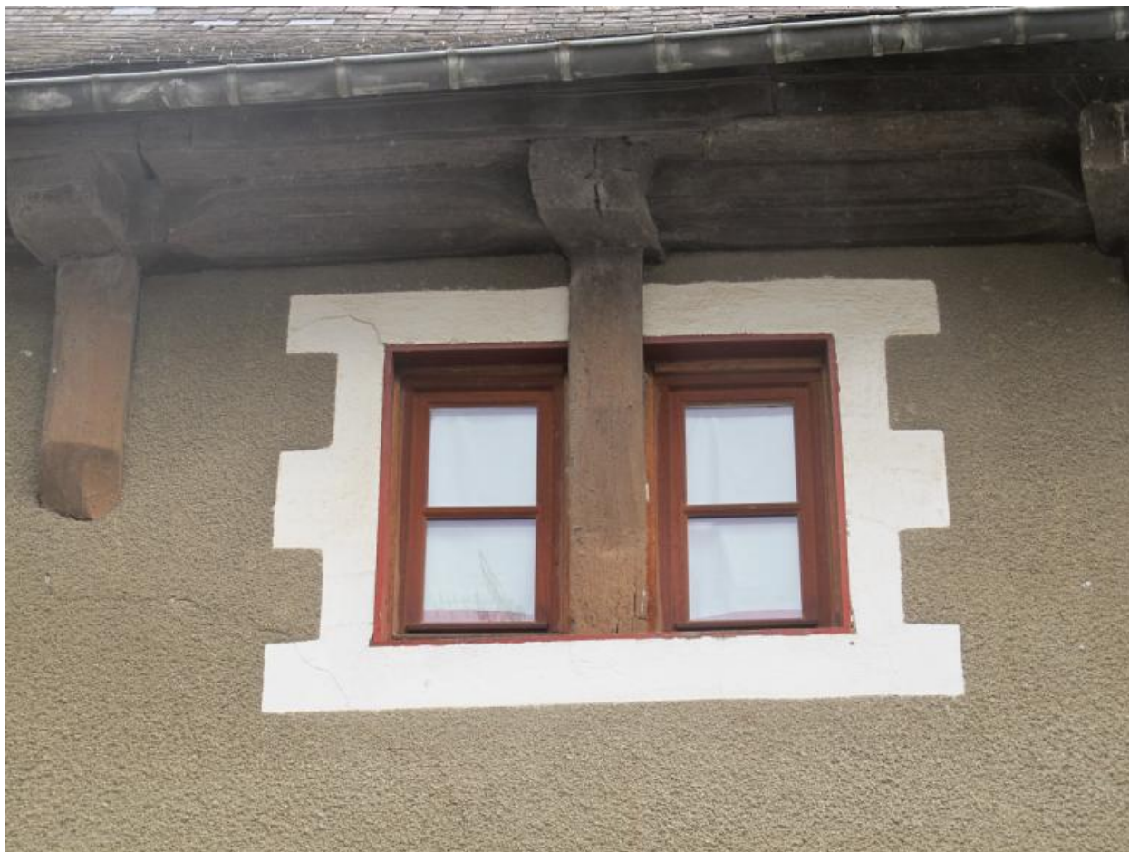
Façade nord. Premier étage, partie ouest, fenêtre
