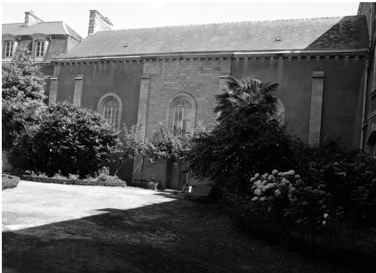
Vue générale sud.
