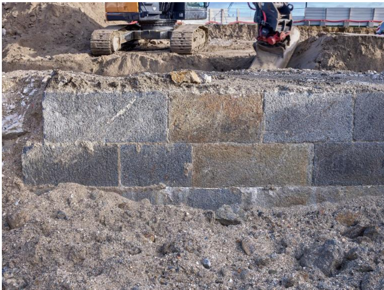
Vue de détail des vestiges du quai de l'avant-port de Saint-Servan : élévation sud-ouest, maçonnerie en pierre de taille de granite (couverture photographique du 22 janvier 2026)
