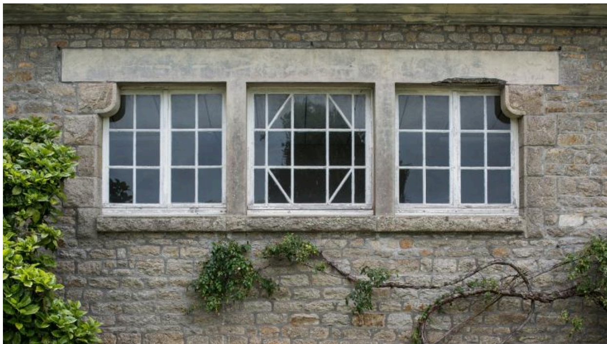
Détail sur des baies de la façade nord de l'aile ouest. Georges-Robert Lefort, architecte, 1929.
