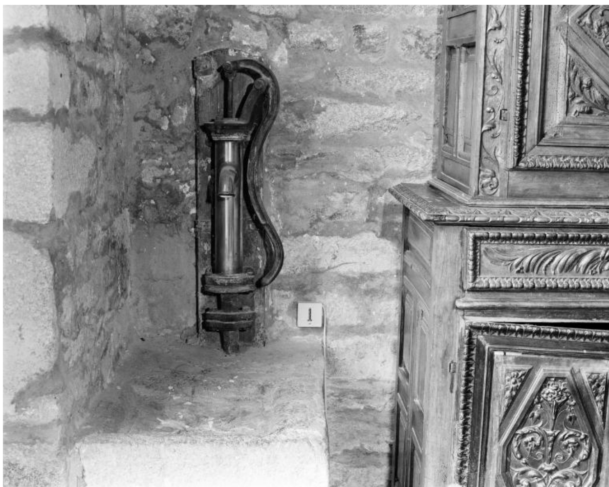
Château, rez-de-chaussée, pavillon est, pièce sud : pompe et évier.
