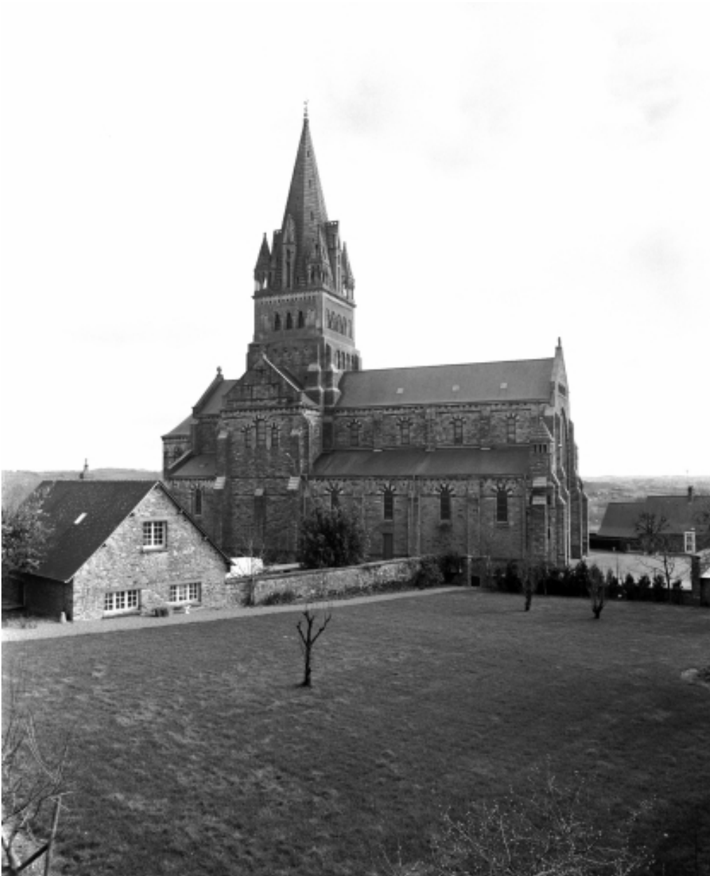
Vue générale nord
