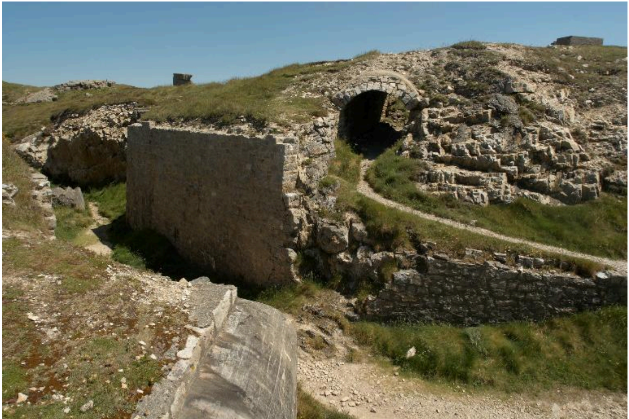
Vue du passage couvert depuis le bunker - poste de direction de tir de type M162a
