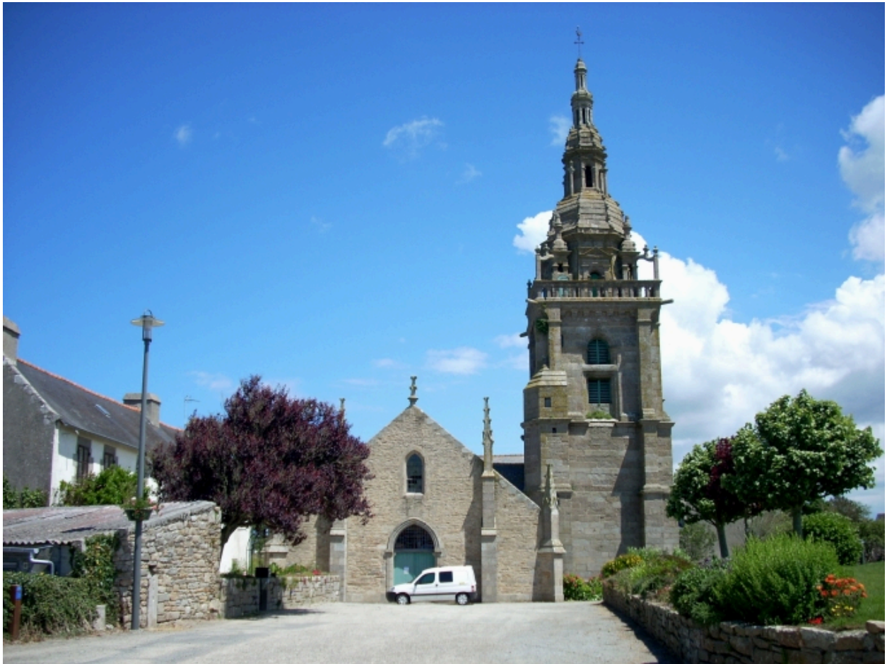
Lampaul-Ploudalmézeau, église paroissiale : élévation ouest
