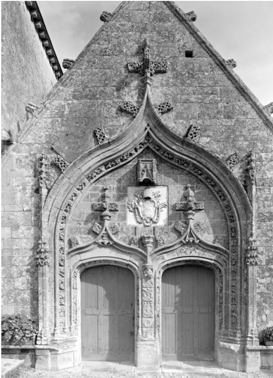
Chapelle Saint-Golven, élévation ouest : le portail (état en 1984)
