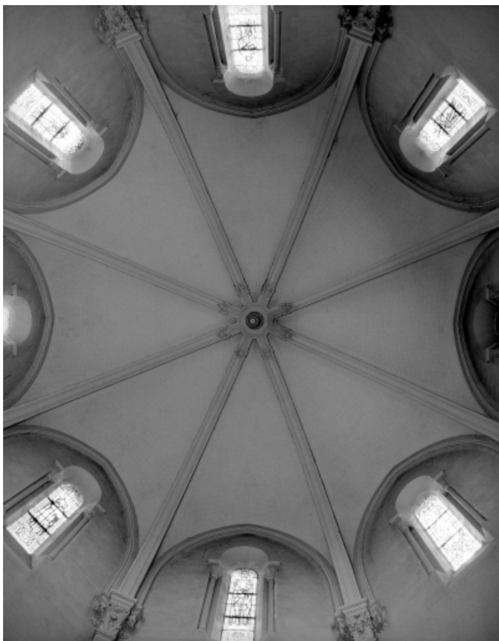
Intérieur, nef, voûtement : vue générale
