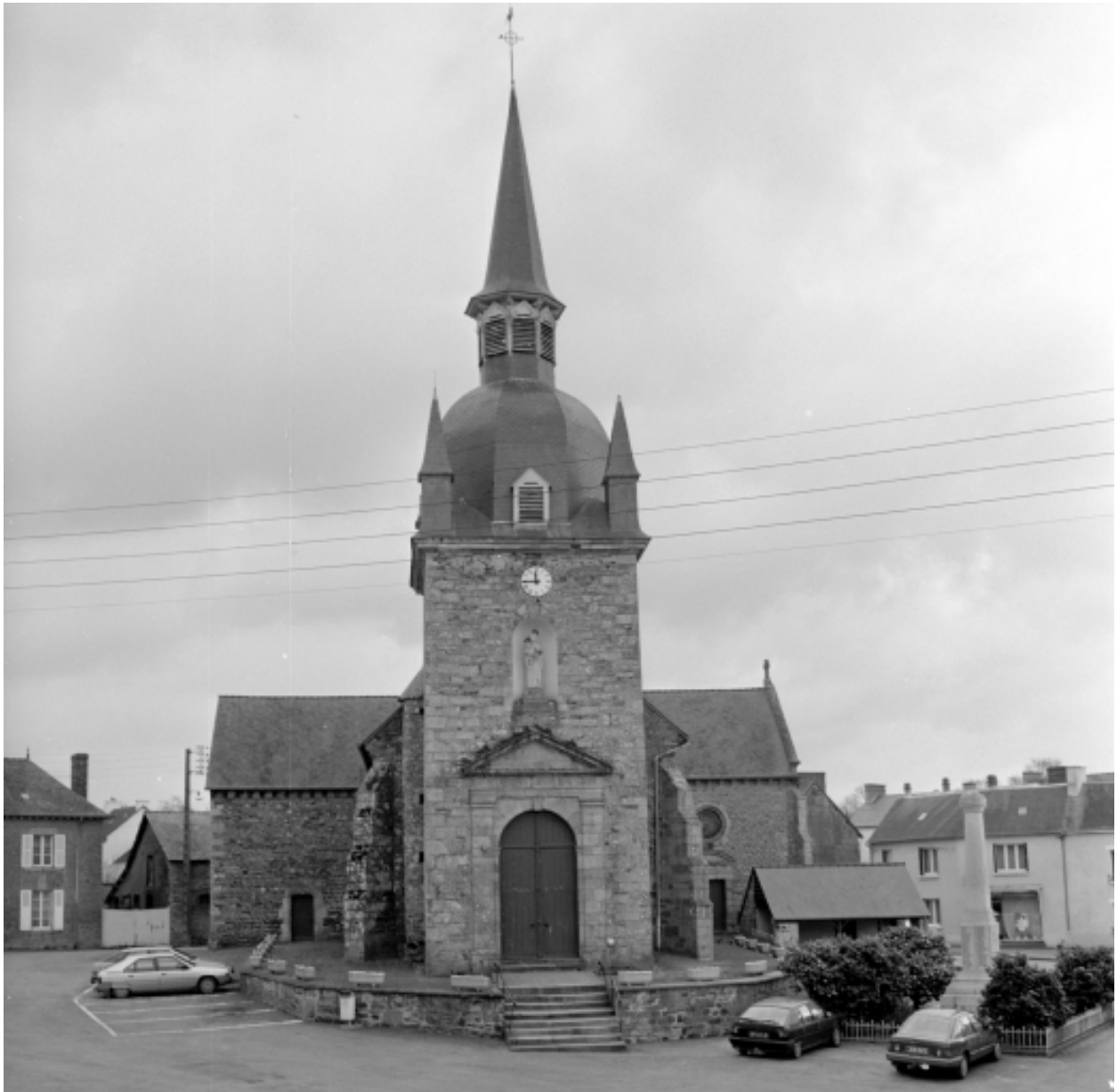
Elévation Ouest : vue générale
