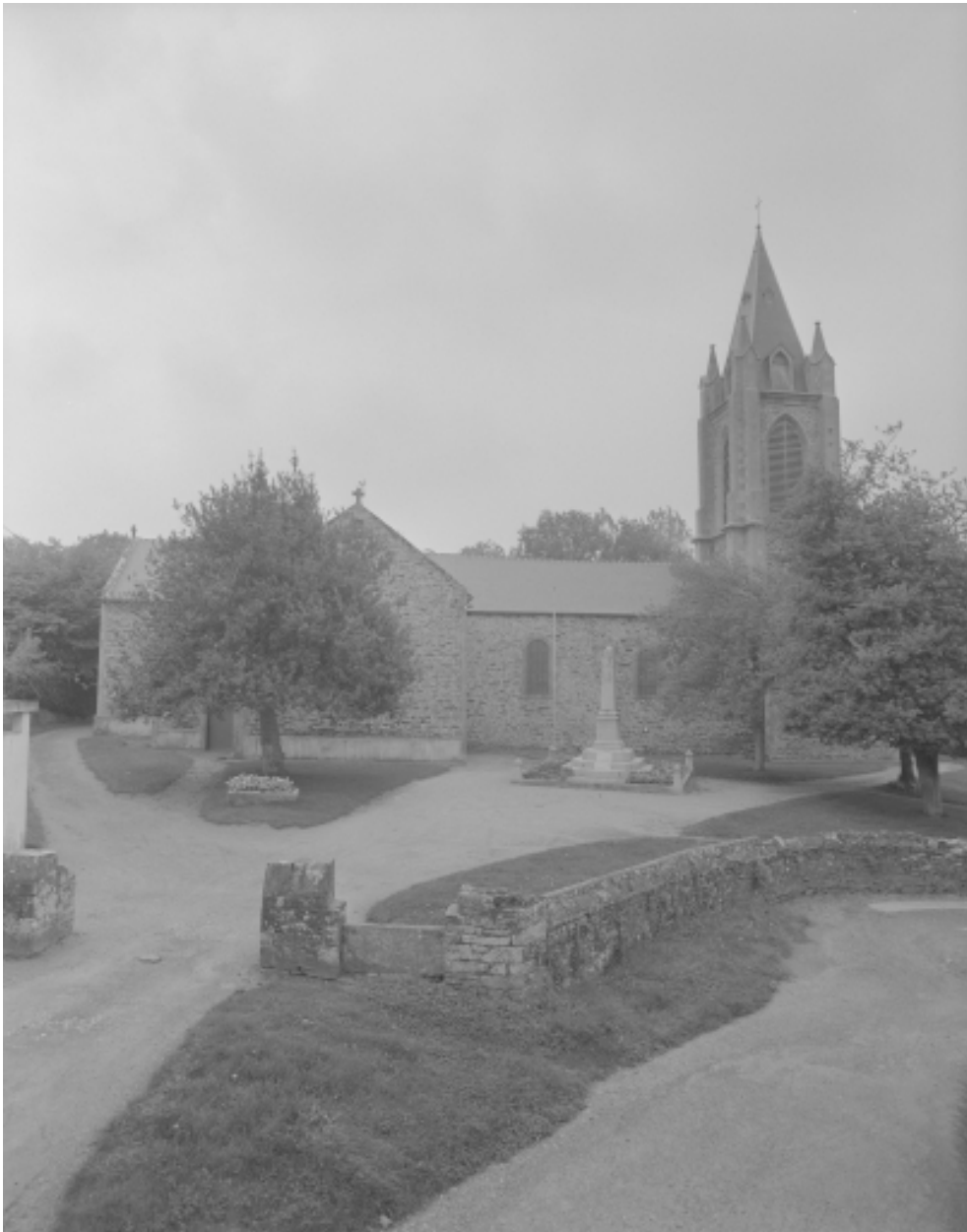
Elévation Nord : vue générale
