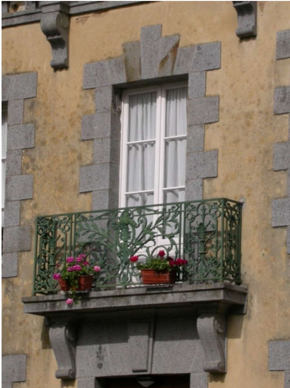
Détail de l'une des baies
