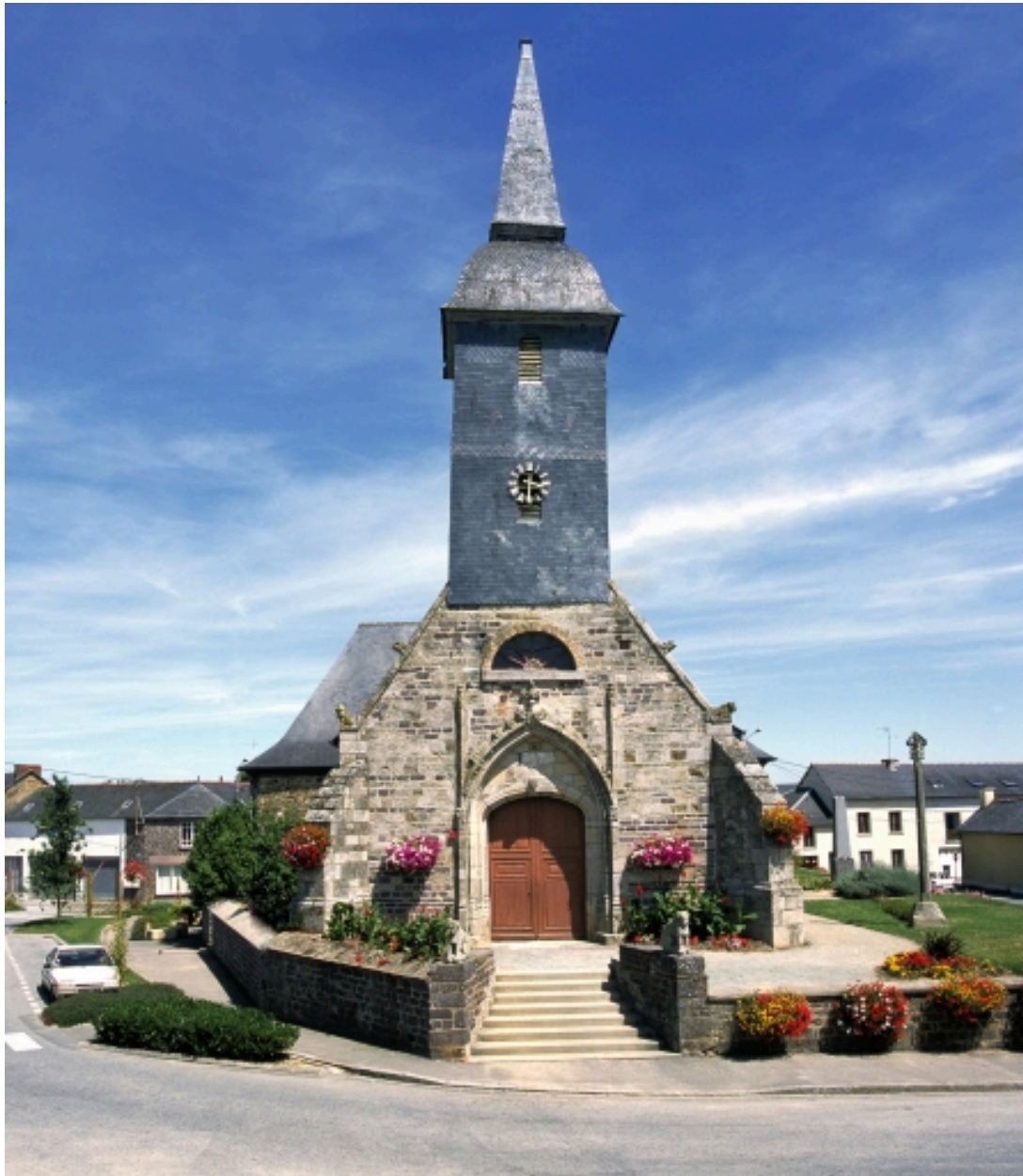
Vue depuis l'ouest
