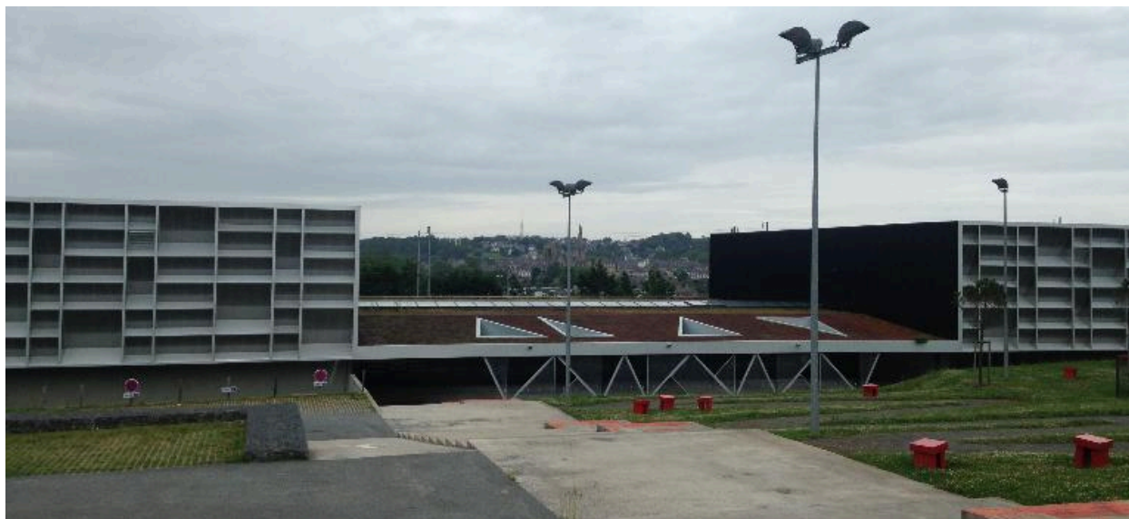
Vue générale prise du sud
