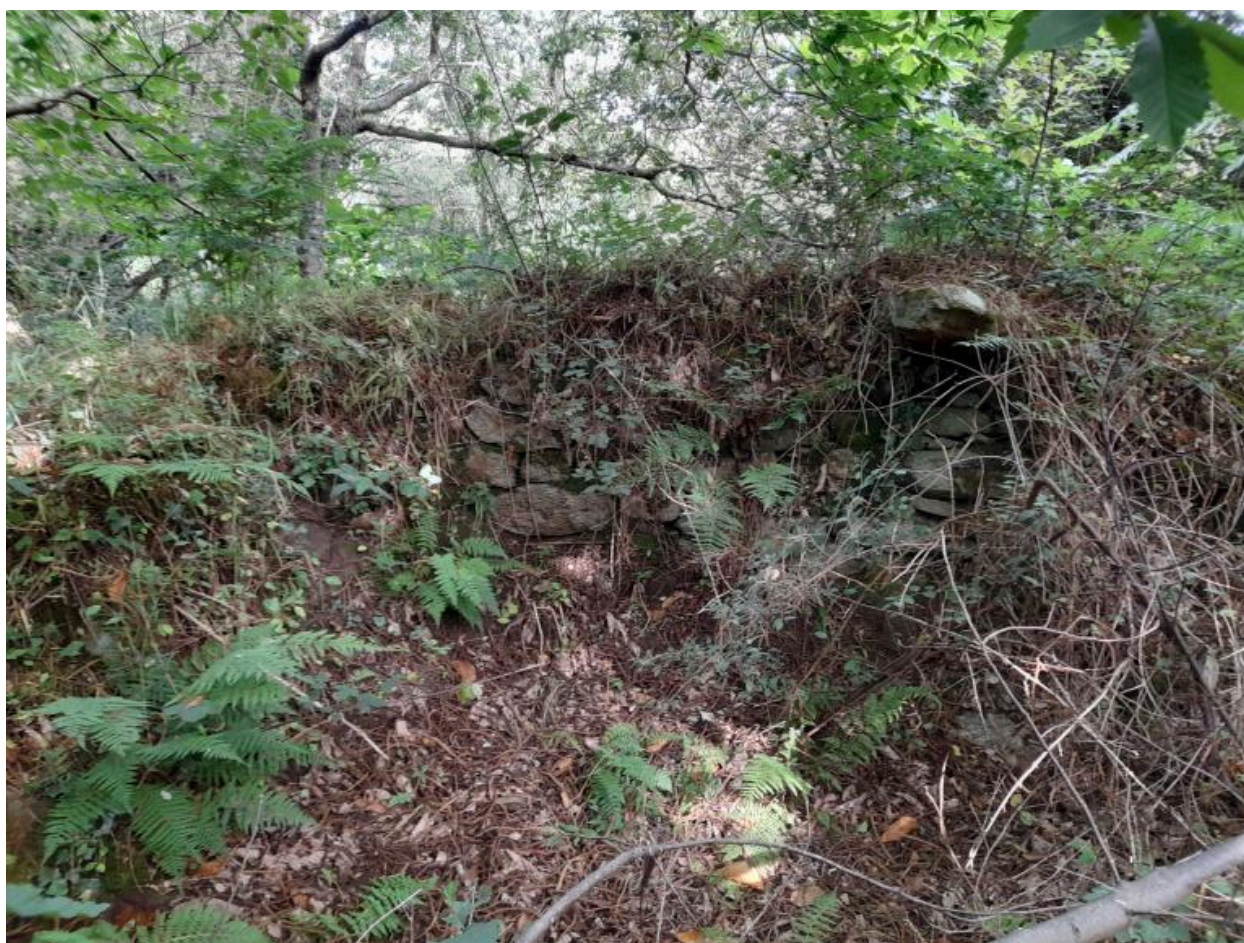
Mur 7, parement est. Détail de la maçonnerie.
