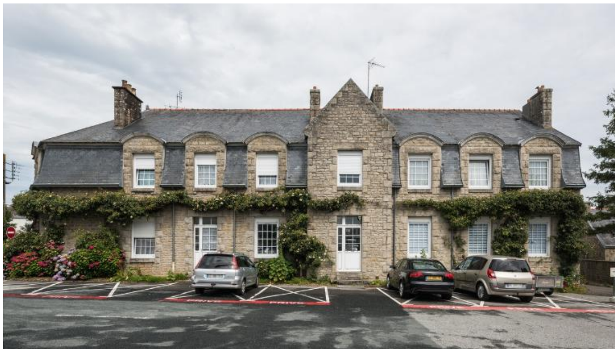
Façade sud de l'infirmerie (aujourd'hui, logements). Georges-Robert Lefort, architecte, 1929. La partie est, à partir de l'avant-corps central, est un agrandissement de 1953.
