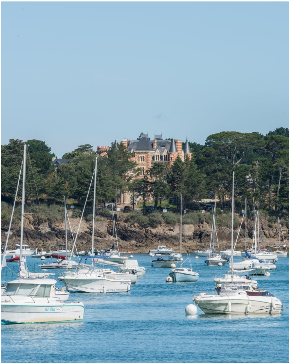
Vue de situation depuis le pont du Frémur
