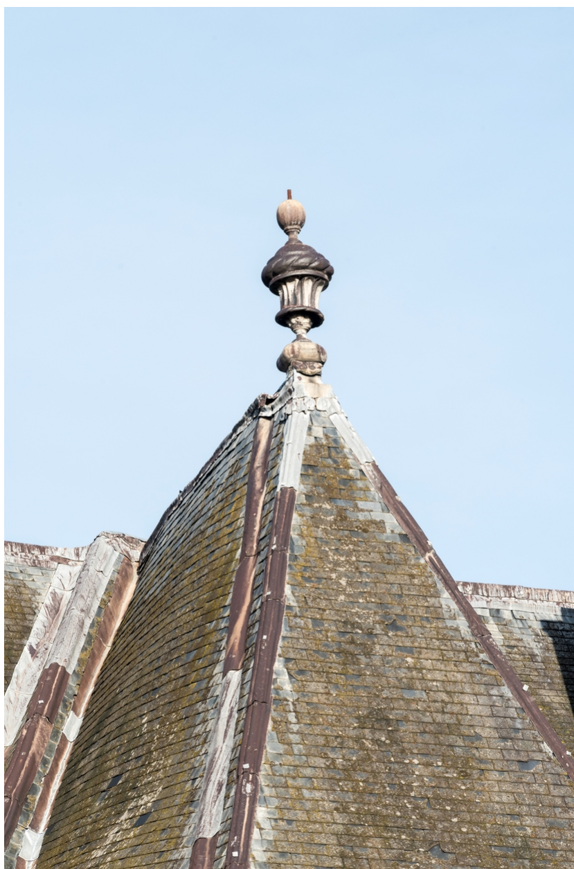
Façade méridionale, détail d'un pot à feu en plomb
