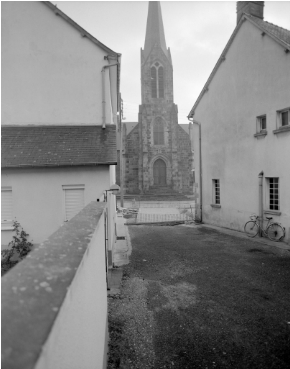
Elévation ouest : vue générale
