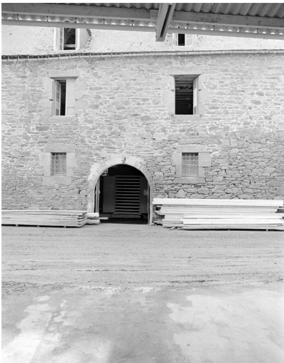
Façade principale, détail : ouvertures.
