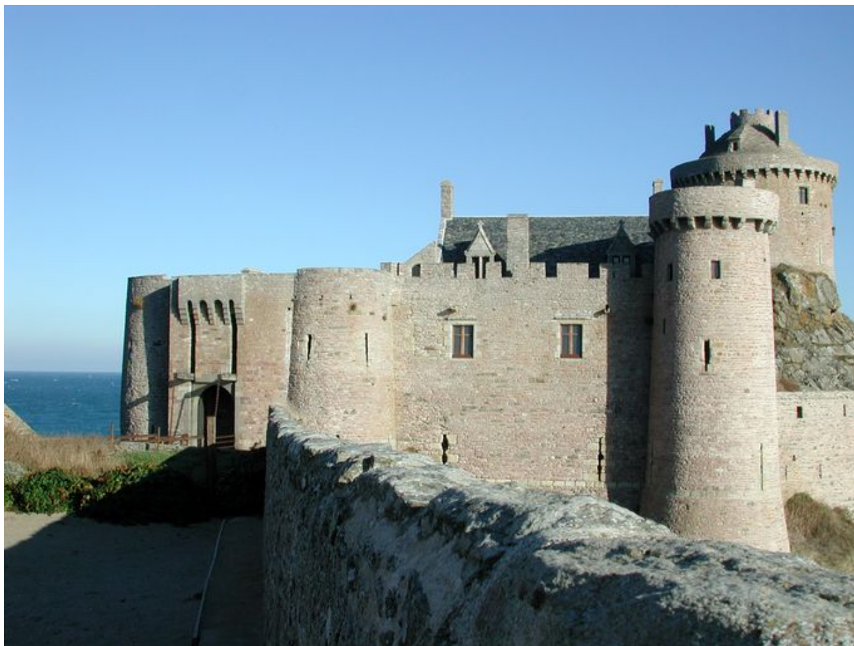
Vue du Fort La Latte
