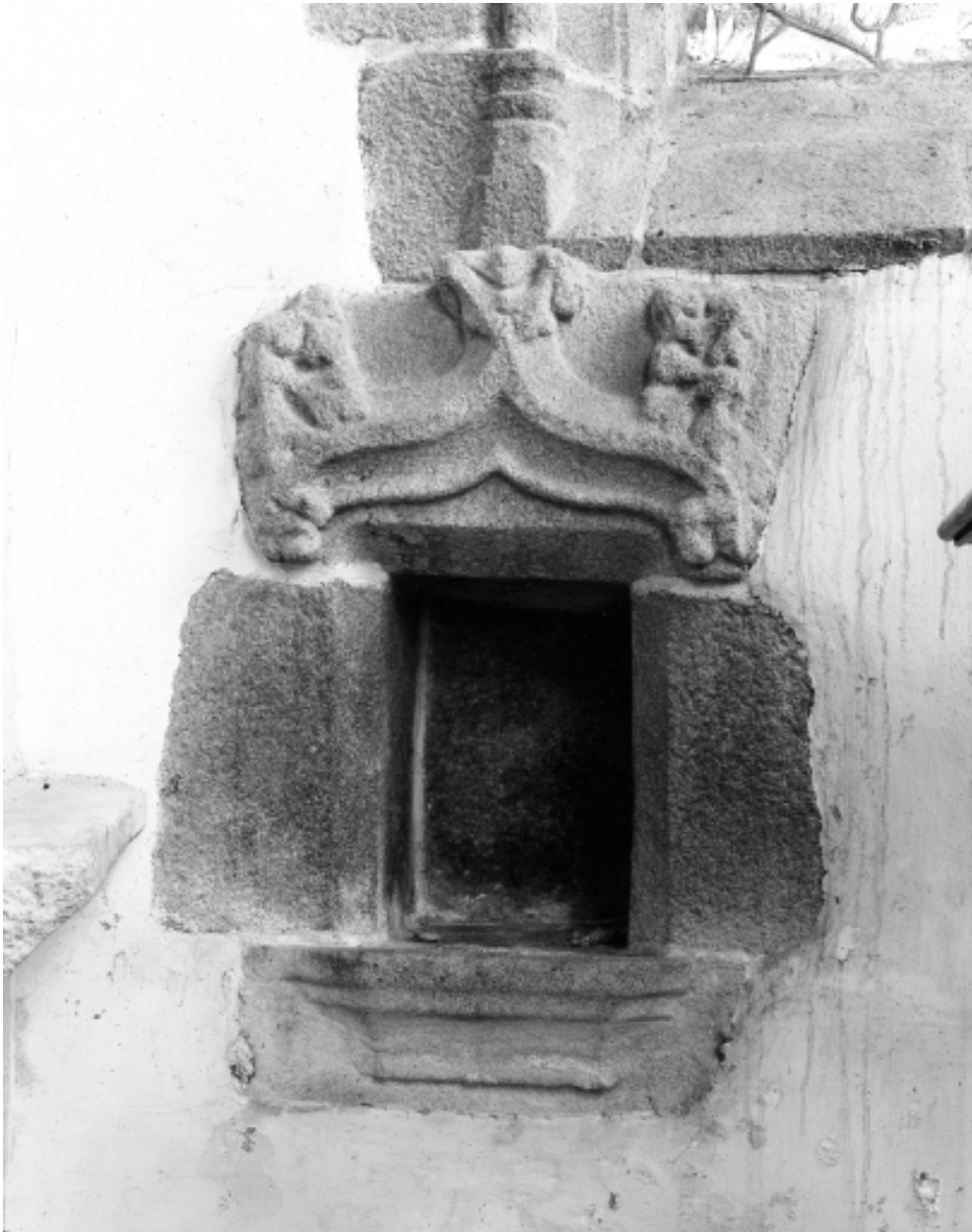
Intérieur, niche : vue générale.
