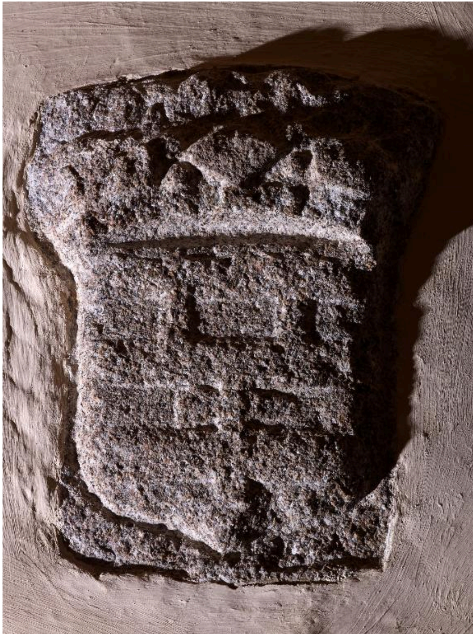
Blason présent dans le sur le mur Sud de la croisée du transept
