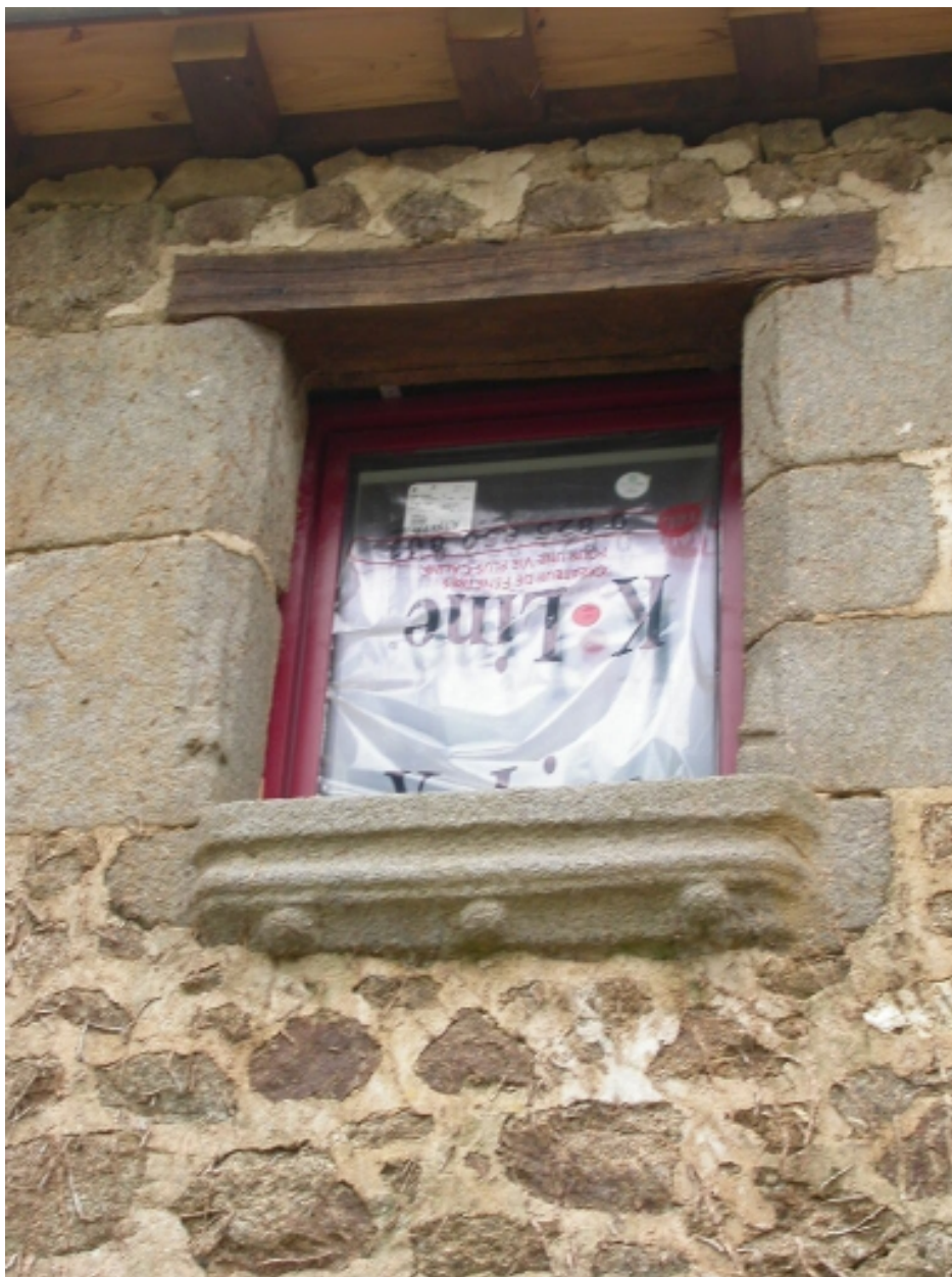
Fenêtre de l'étage
