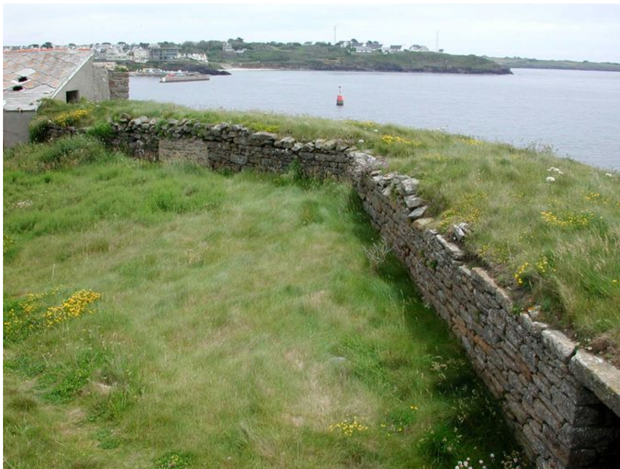
Vue de détail du parapet (état en 2006)
