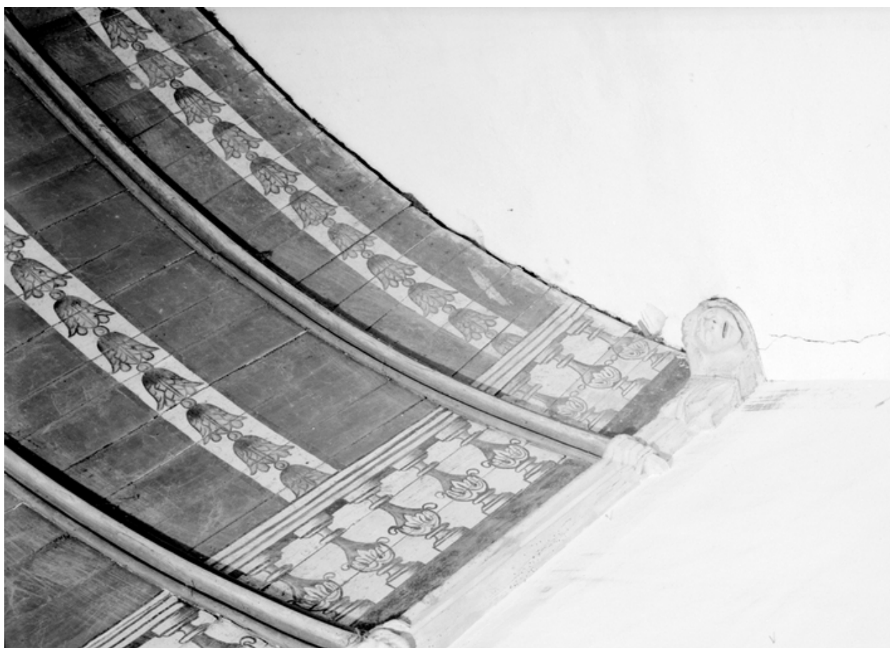
Sablère du mur ouest du bras nord du transept
