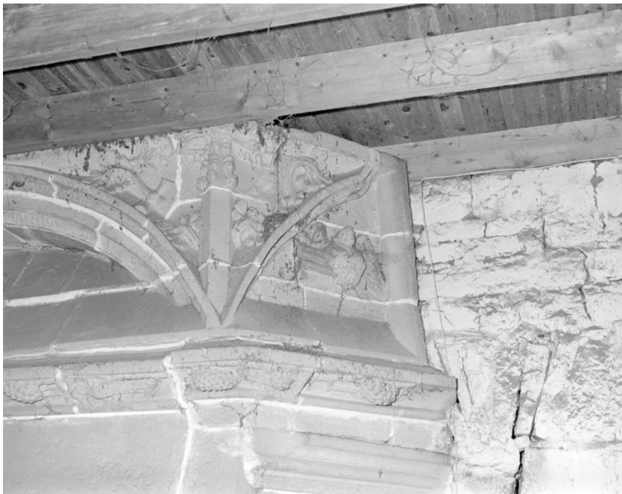
Cheminée, premier étage : détail ange droit
