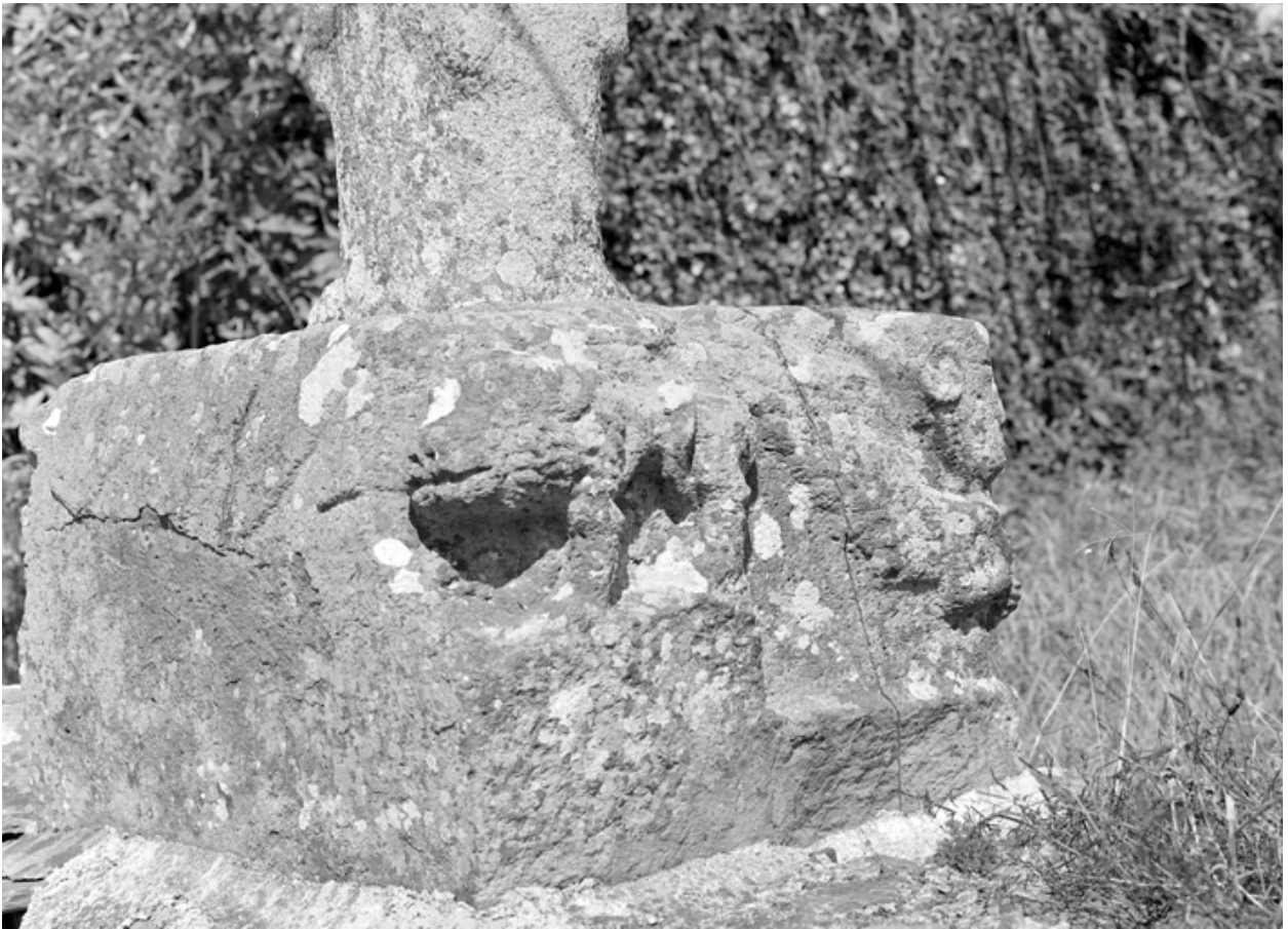
Croix monumentale, socle vu de l'angle sud-ouest.
