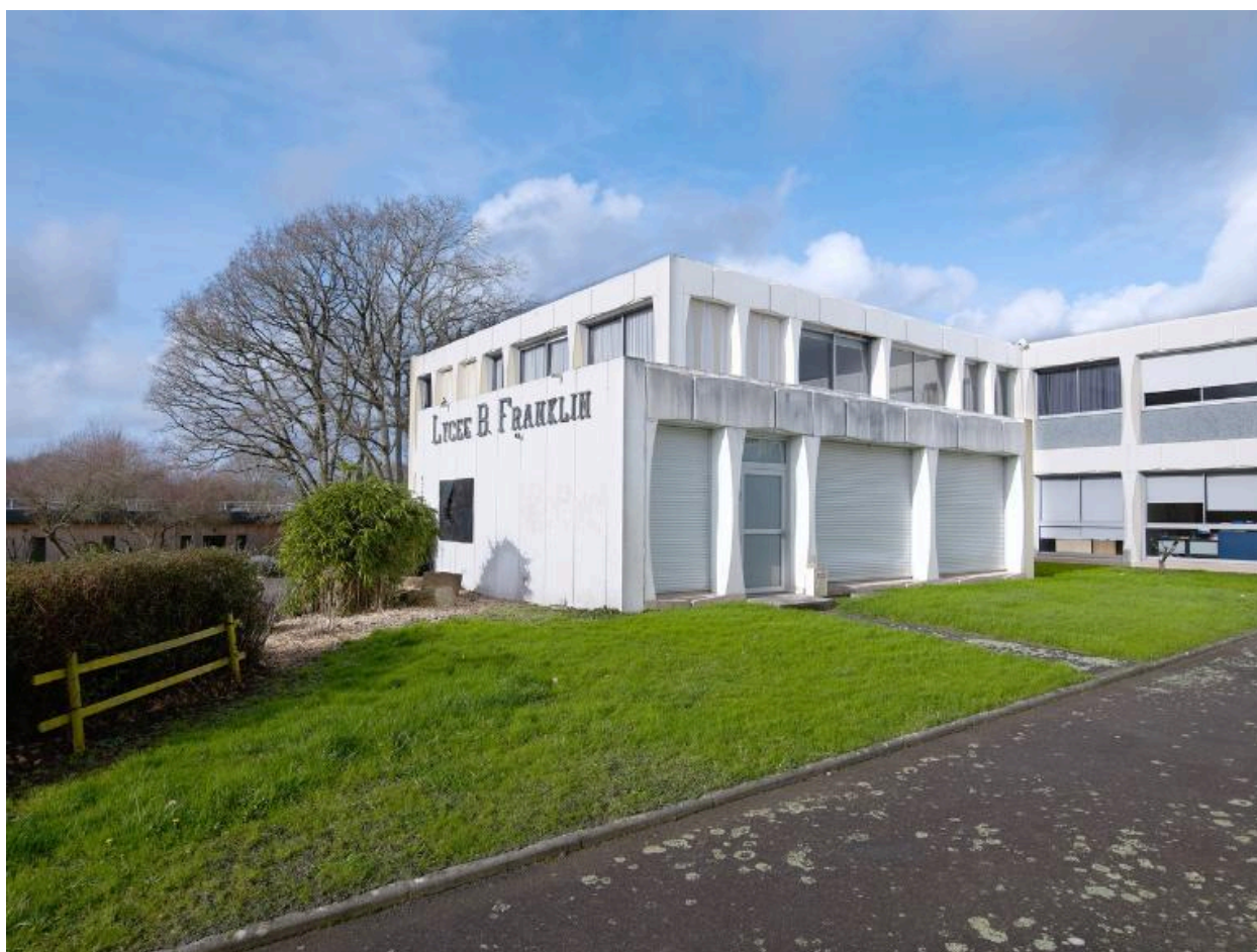
L'infirmierie, l'étage de l'administration et une partie de la façade de l'externat (Yves Guillou, architecte, 1980), vue prise du sud-ouest.
