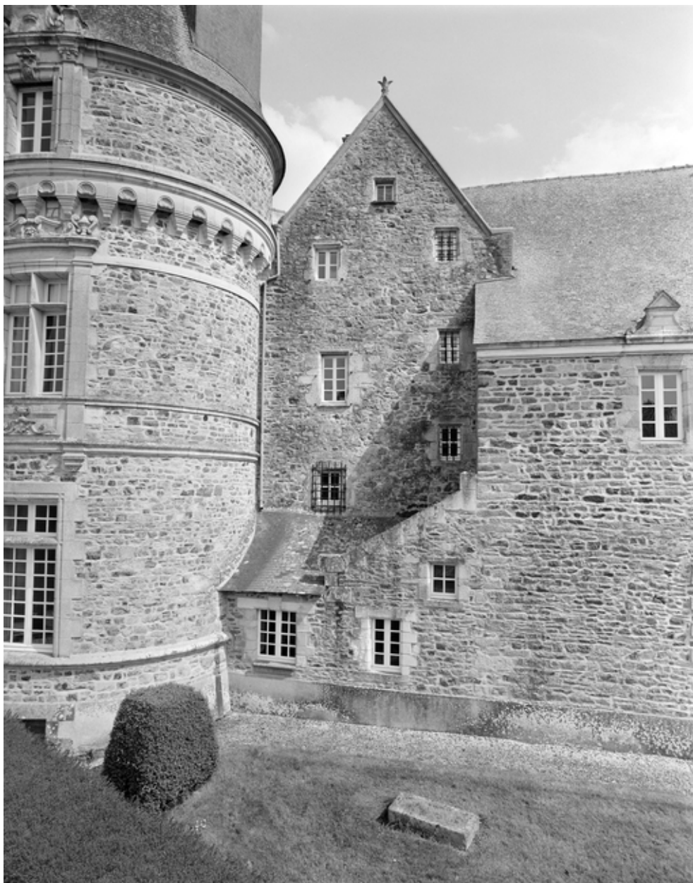
Partie ancienne, face ouest.
